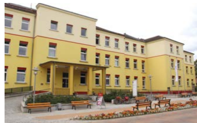
Für das ambulant-stationäre Gesundheitszentrum wird die erste Etage des Sana Krankenhauses in Templin ausgebaut (Foto: Sana Kliniken Berlin-Brandenburg).
